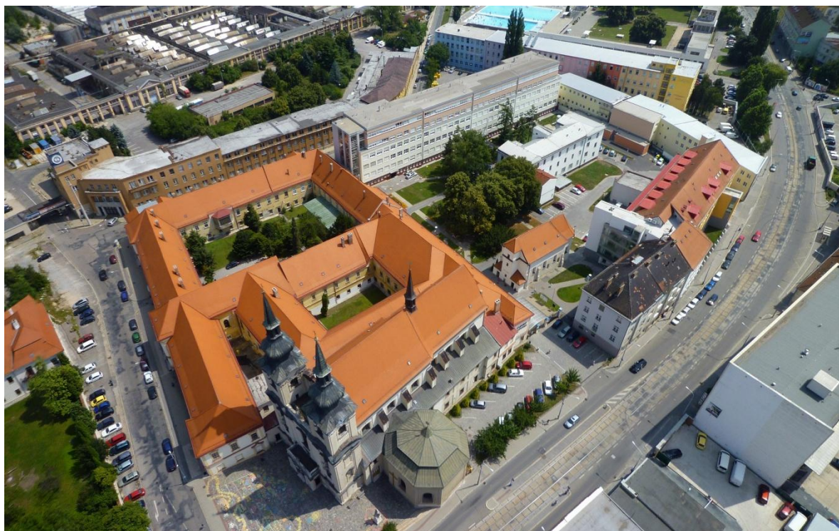
Obr. 1: Letecký pohled na Vojenskou nemocnici Brno
